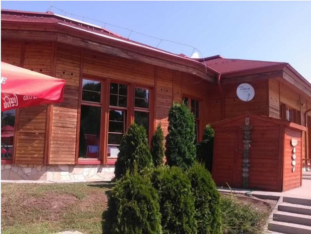
5. fürdőépület csatlakozási pontja
